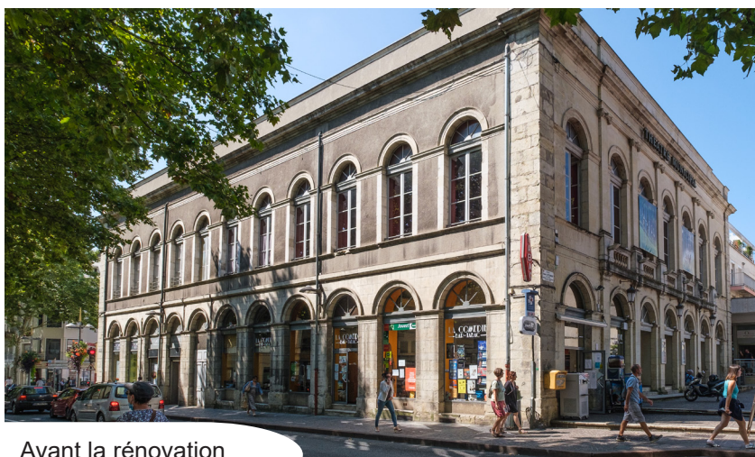
Avant la rénovation
