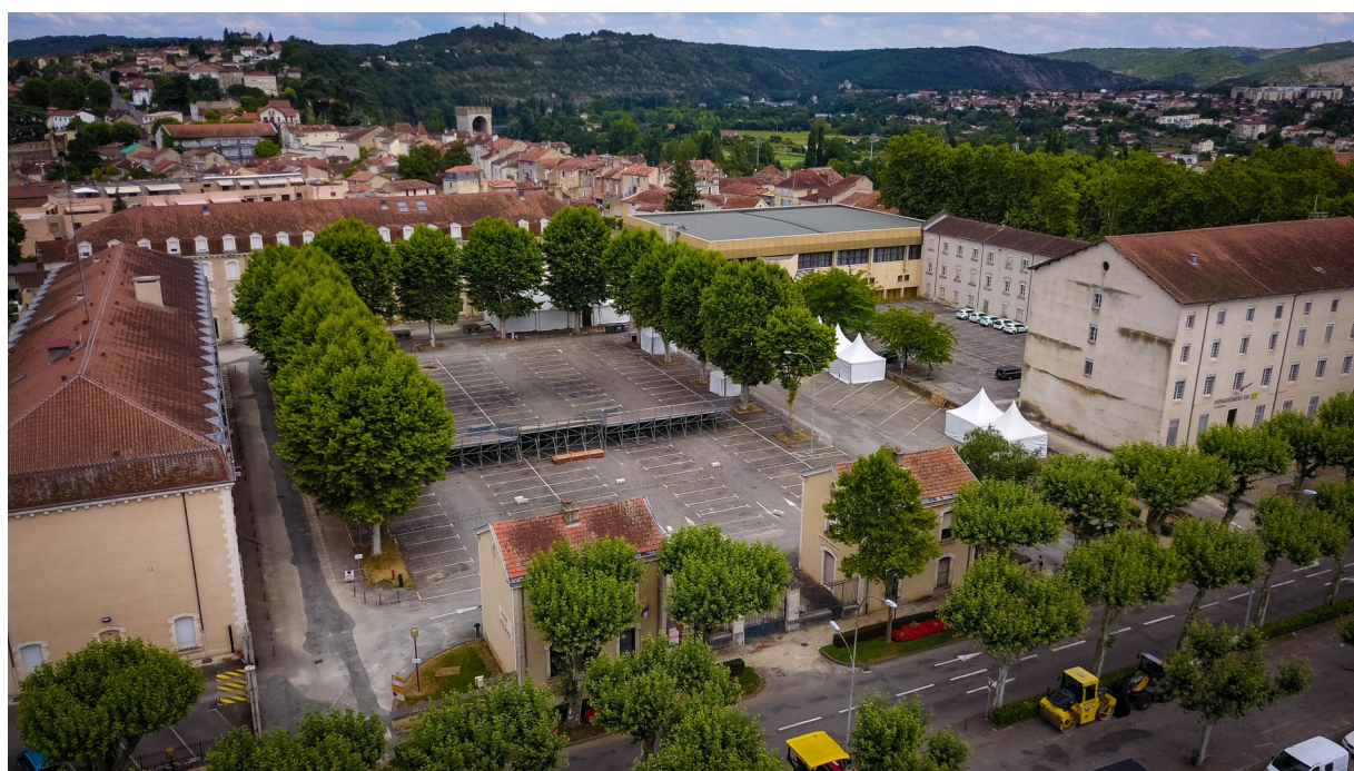
Le musée de la Résistance, de la Déportation et de la Libération du Lot avant travaux en 2018.
