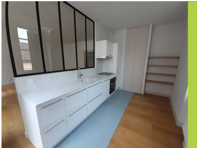
> Une rénovation menée dans le cadre de l'OPAH-RU sur Cahors
