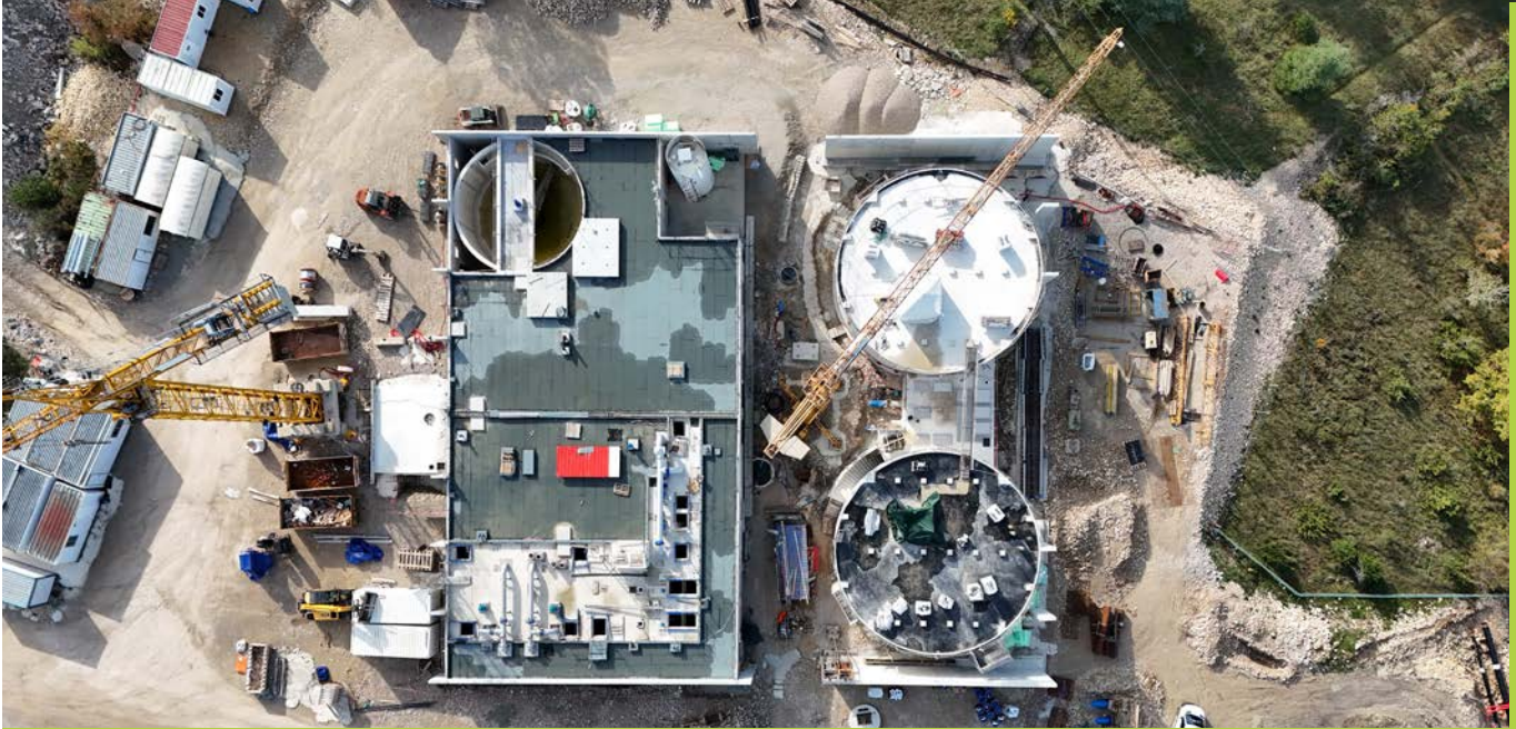
> Les travaux de l'UFE
