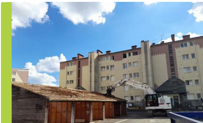
> Travaux de rénovation de logements sociaux à Terre-Rouge
