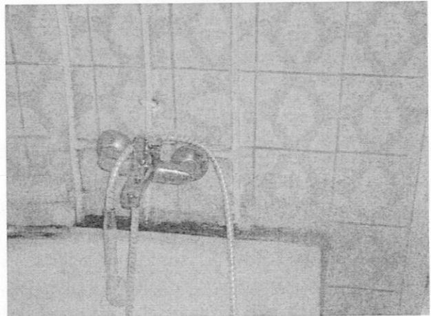
SDB/ WC : joints défectueux ; signes d'infiltration en raison de fuites, sols dégradés.
