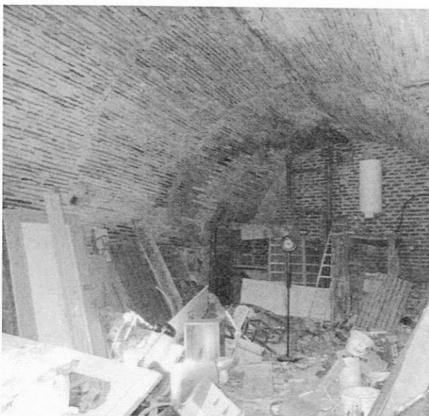
Cave : encombrée par des poubelles
