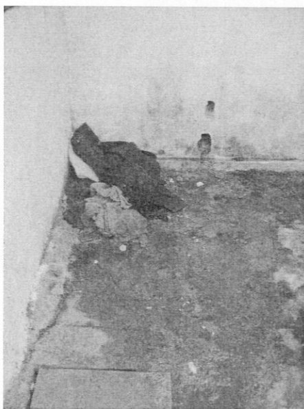
Les trous sur le mur servent à évacuer les eaux usées du log 1 (RDC, actuellement vacant).
