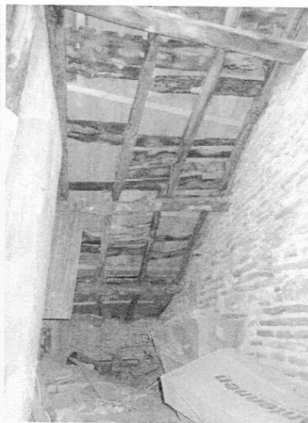
Etat de la charpente
