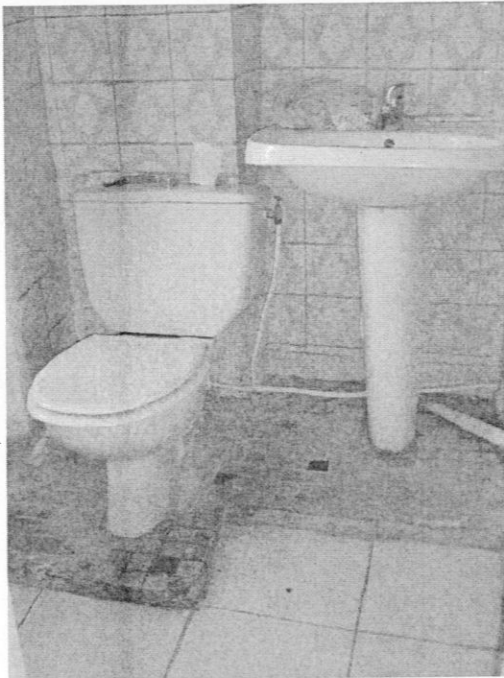
SDB/ WC : joints défectueux ; signes d'infiltration en raison de fuites, sols dégradés.
