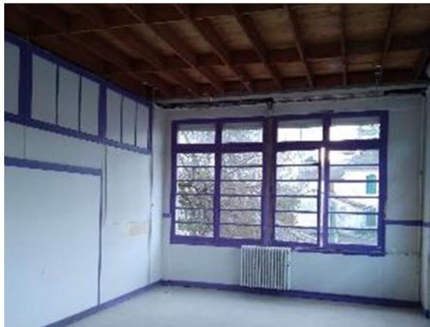
Remplacement des menuiseries bois simple vitrage par des menuiseries aluminium double vitrage
