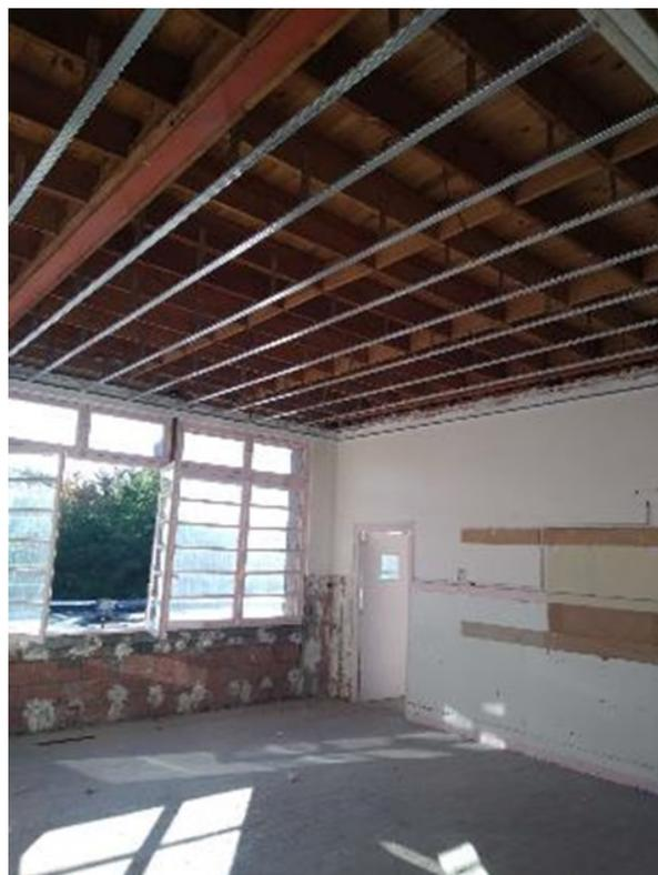
Réalisation des coupe-feu, isolation par l'intérieur, isolation des planchers bas
