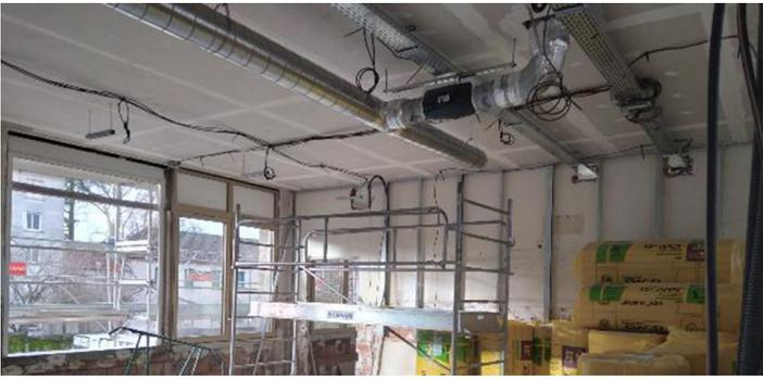
VMC simple flux avec horloge et régulation sur sonde CO2
