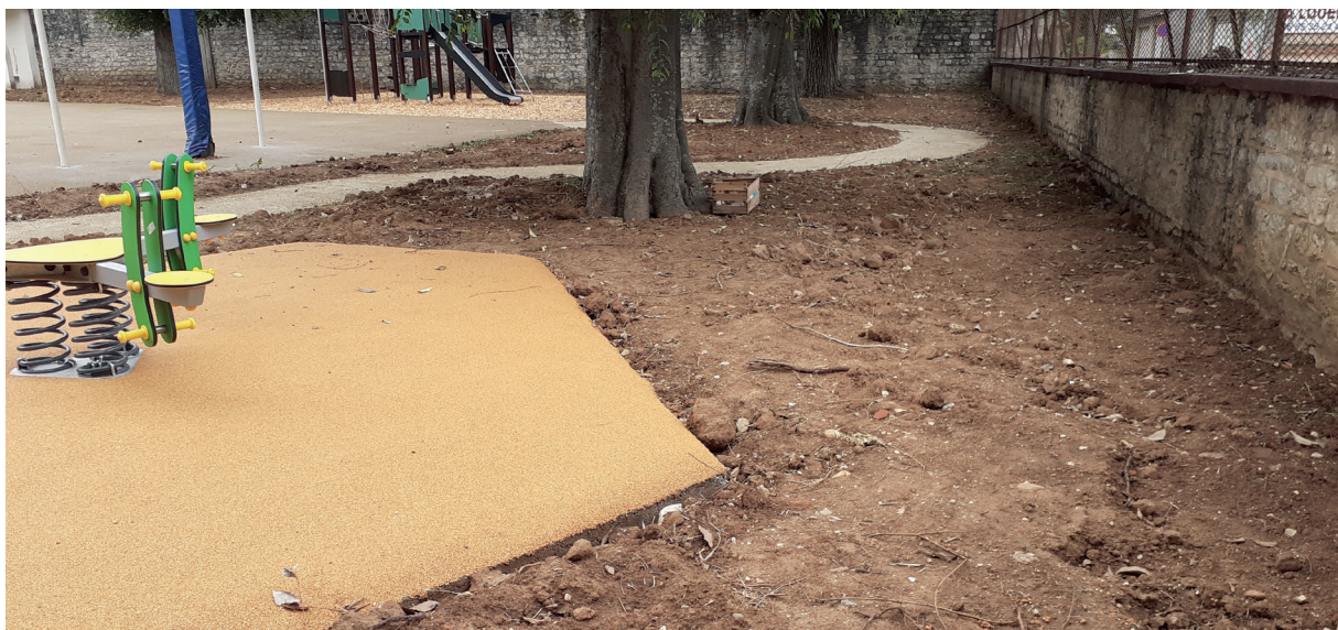
Aménagements de la nouvelle cour à l'école Jean-Calvet. Engazonnement et plantations en cours (la saison idéale pour les plantations étant l'automne)
