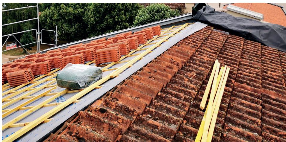
Refection de la toiture à l'école élémentaire Marthe-Durand
