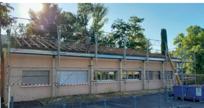
Intervention de réparations multiples à l'école Marthe-Durand
