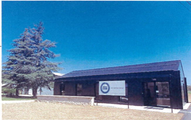
Centre de production de Parnac (46) et entrepôt logistique des produits de Biocontrôle de M2i - Crédit photo M2i Group
