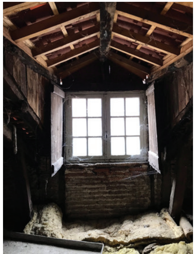
Combles avant travaux
